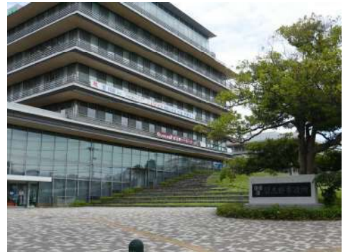
習志野市役所庁舎
