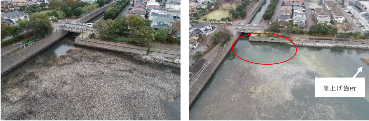
干潟内堆積物除去箇所(赤丸内)※左:除去前、右:除去後
