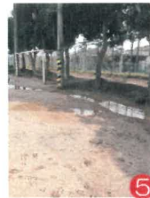
⑤ 雨水抑制の為、校庭の表面貯留を行っています。
