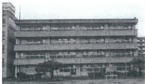
校舎外観(改修前)
