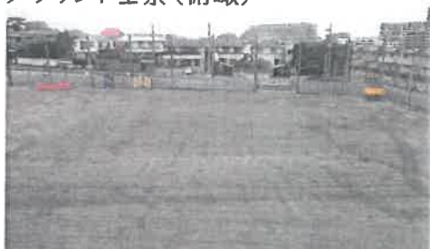
グラウンド全景(俯瞰)
