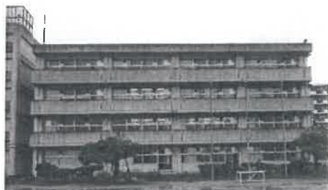
校舎外観(改修前)
