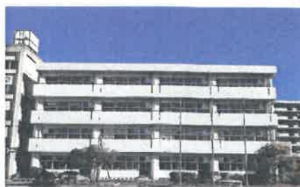
校舎外観(改修後)外部塗装改修 バルコニー手摺塗装改修 バルコニー防水改修
