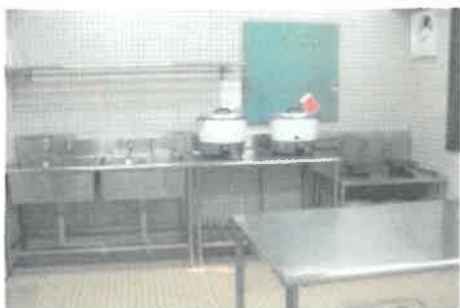
現在では使用されていない厨房
