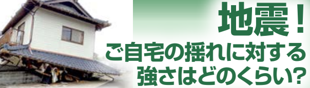
平成28年熊本地震の被害状況
