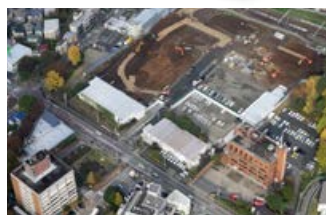
▲新庁舎建設工事の状況(左下は旧庁舎)
