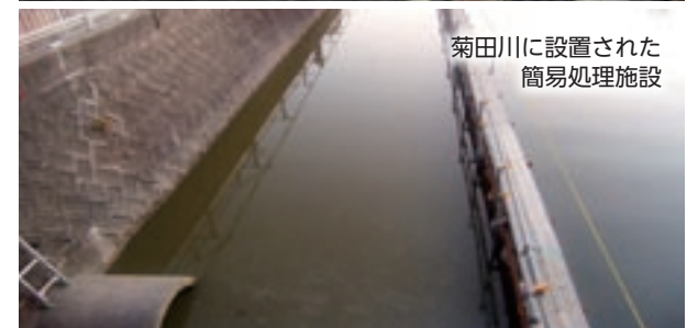
秋津1号汚水幹線 仮排水管設置状況
