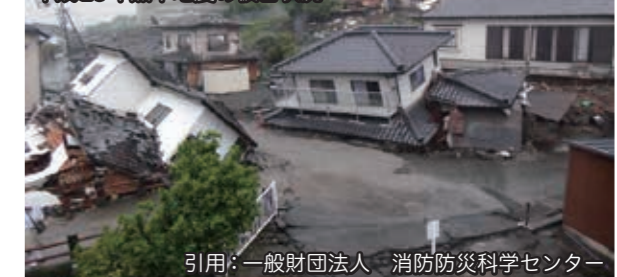
平成28年熊本地震の被害状況
