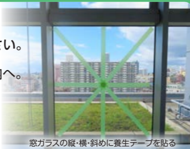
窓ガラスの縦・横・斜めに養生テープを貼る
