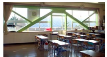
小・中学校耐震補強大規模改造工事 (写真は袖ヶ浦東小学校)
