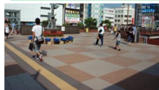
JR 津田沼駅北口 ペデストリアンデッキ (横断歩道橋) 改修工事
