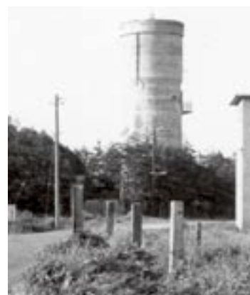
かつて泉町にあった陸軍の給水塔
