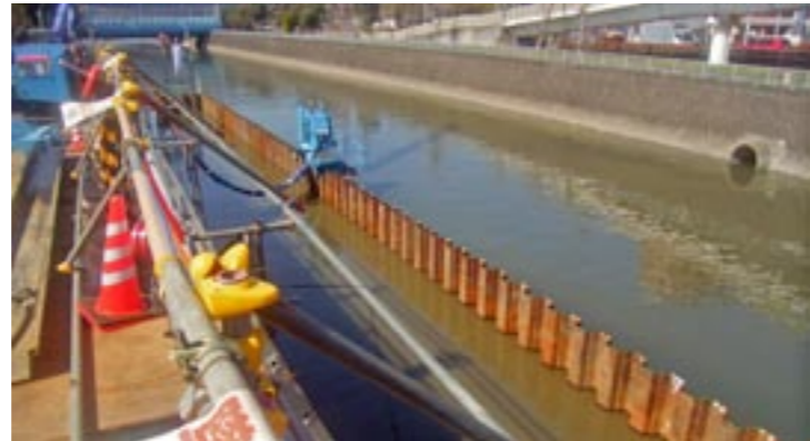
急ピッチで4月中に完成させる菊田川の簡易污水处理施設
