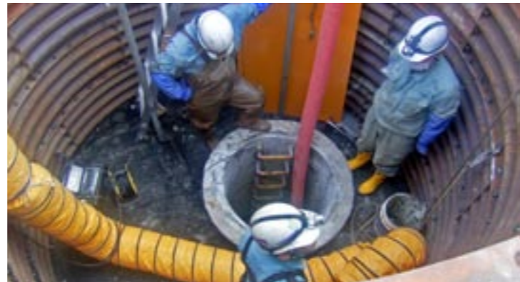
香澄地区で大きく陥没した下水道幹線マンホールの修復工事
