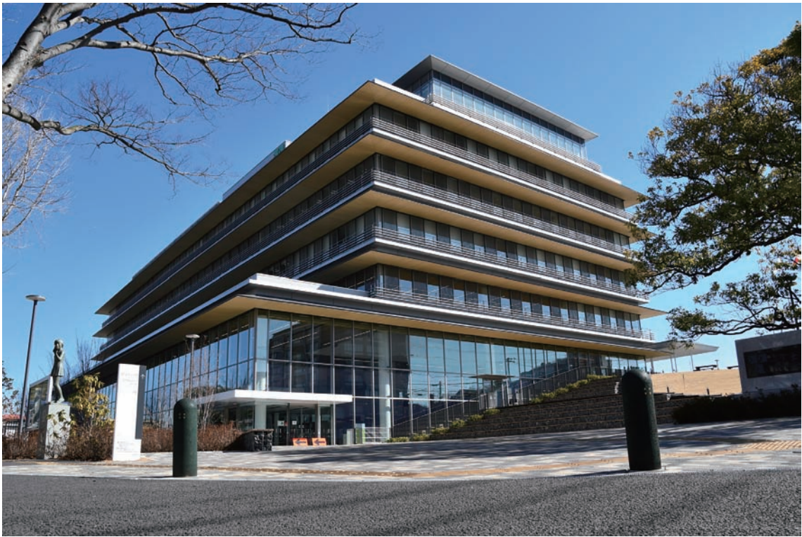
習志野市庁舎(平成29年4月30日竣工)
