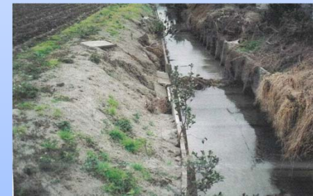
老朽水路の改修
