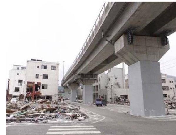
橋脚の耐震補強 （東日本大震災でも地震動による損傷無し）
