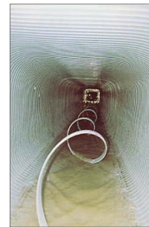
管渠耐震化工法(更生工法の採用)
