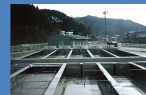
さけ・ます種苗生産施設
