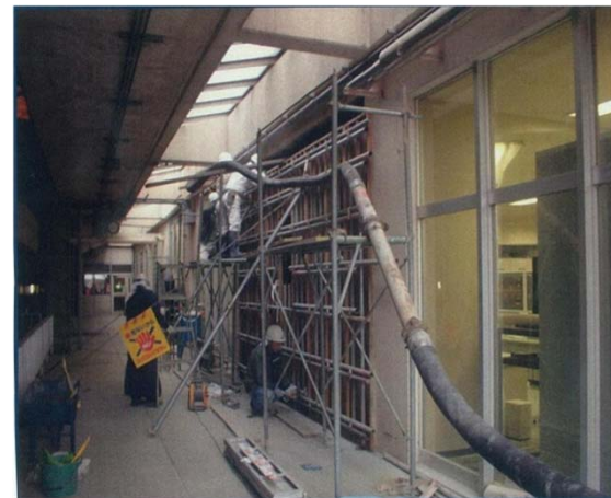
水処理施設の耐震補強(コンクリート打ち増し)
