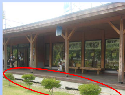
沈下した基礎部の補修、補強
