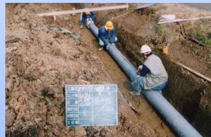
農業用水路の設置
