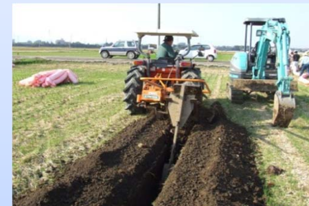
暗渠排水の設置
