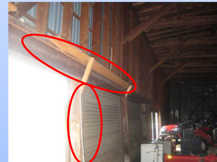
柱・梁の歪みの補修、補強
