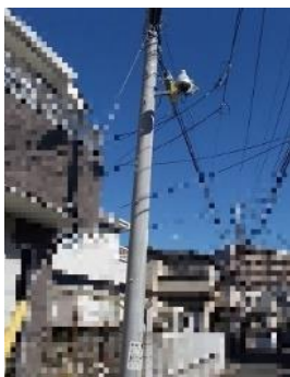
電柱に設置した 場合のイメージ
