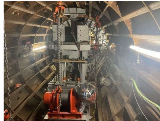
組立完了（裡側）
