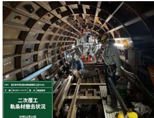
軌条材撤去状況
