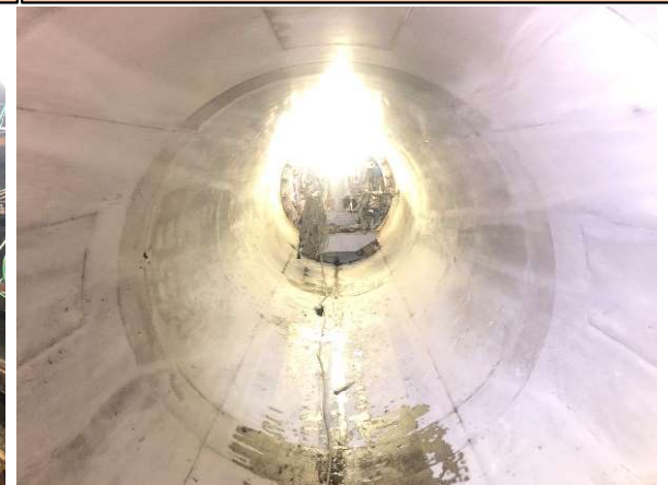
コンクリート打設完了(写真③)
