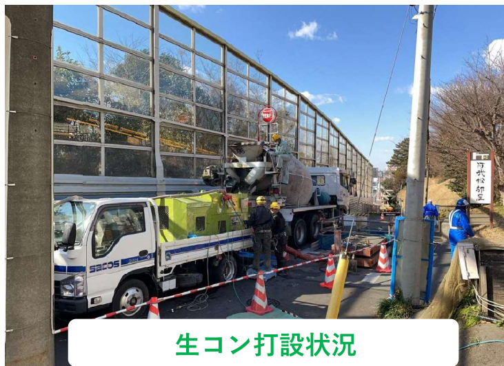
到達立坑部生コン打設作業状況（令和4年12月）
