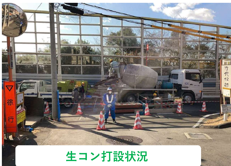
到達立坑部生コン打設作業状況（令和4年12月）
