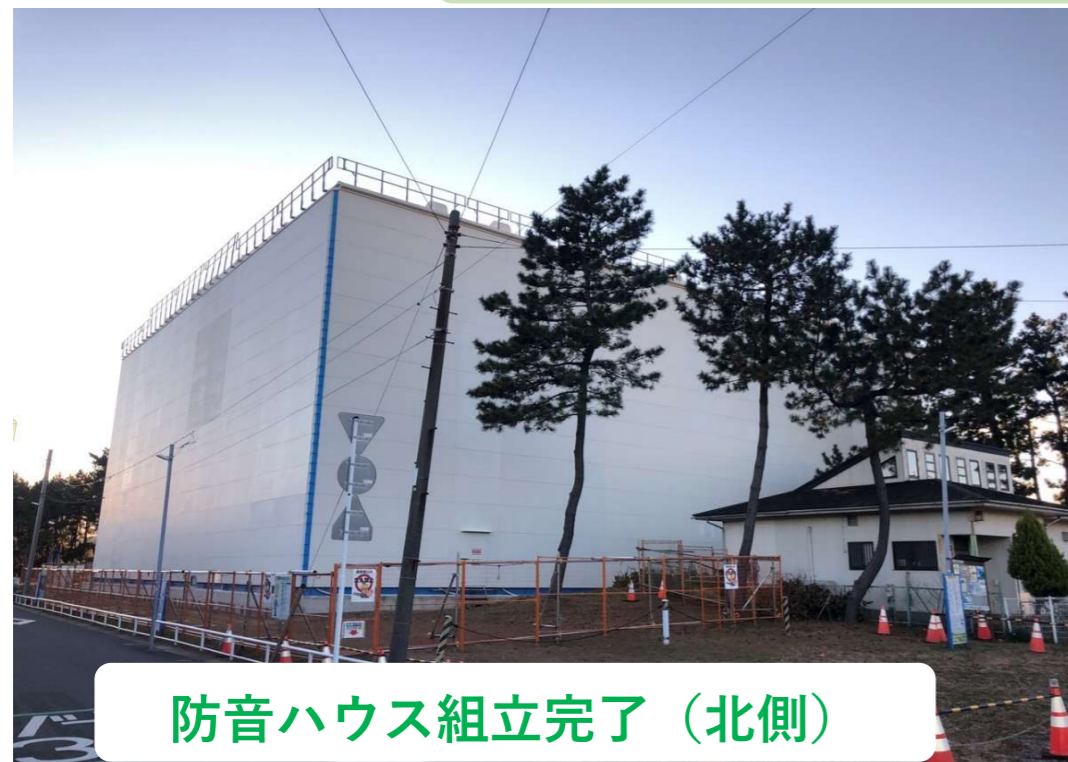
袖ヶ浦運動公園内作業状況（令和3年12月）
