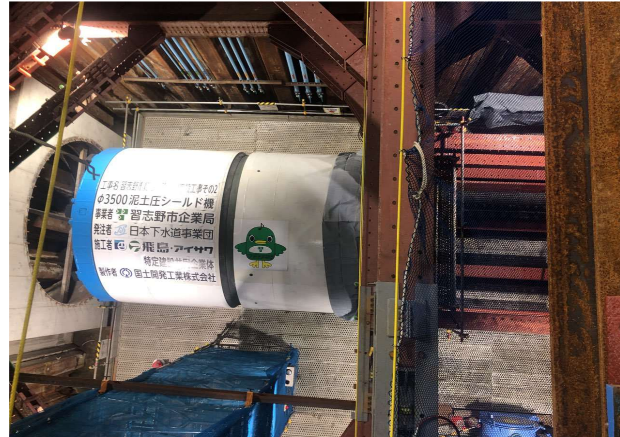
シールド機組立完了（発進立坑内）
