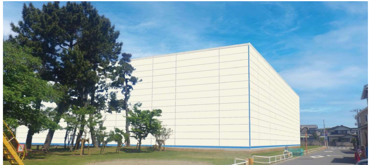
防音ハウスイメージ図 (縦34m×横34m×高さ14m)
