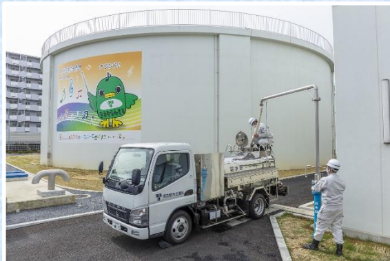
給水塔から給水車へくみ入れる様子
