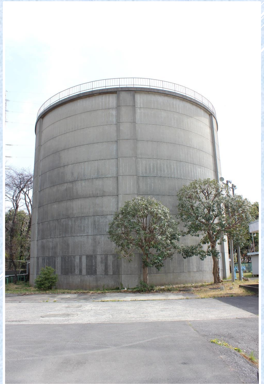
第3給水場の配水池(現在)
