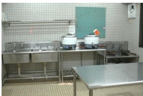
現在では使用されていない厨房
