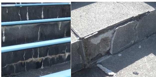
亀裂や破損
