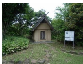
鷺沼古墳石棺覆屋
