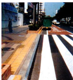
▲横断歩道等の接続部に雨水が溜らない円形側溝を配置した例
