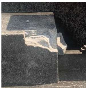
スタンド内階段の破損
