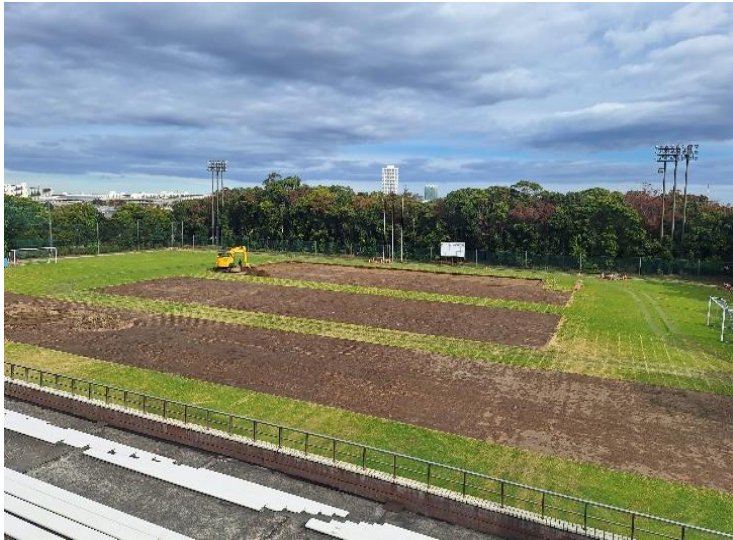
2. 路盤整地(令和8年1月13日時点)
