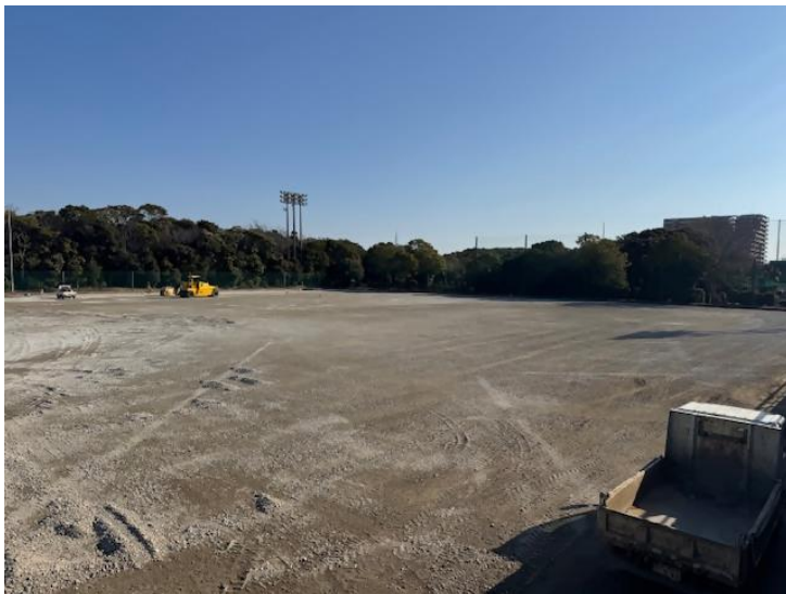
2. 路盤整地(令和8年1月13日時点)
