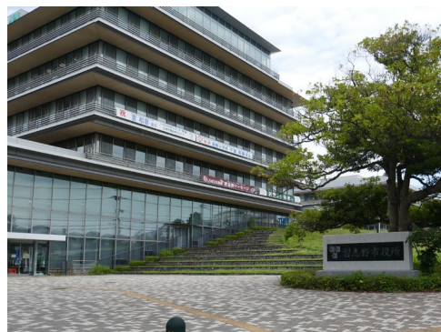
習志野市役所庁舎
