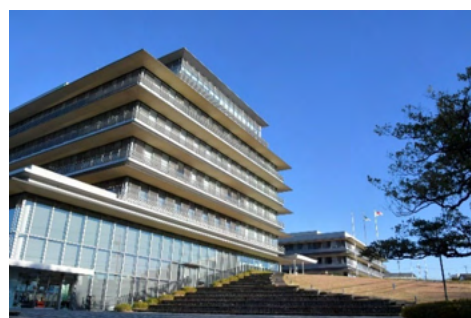
習志野市役所庁舎
