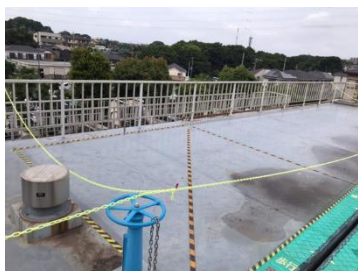
第2給水場№2酸化槽天井 外部写真
