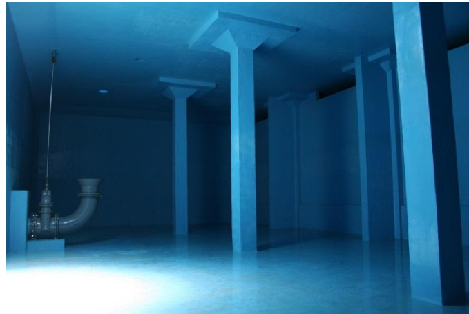
耐震補強された配水池の内部
