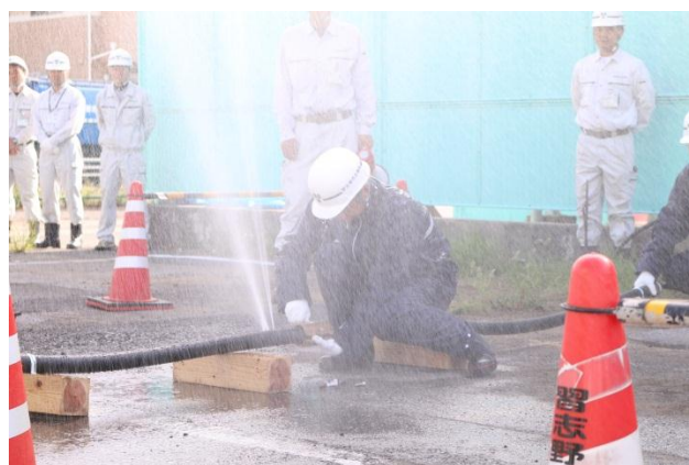
災害復旧訓練
