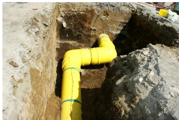
本支管工事の状況（ポリエチレン管へ更新）
