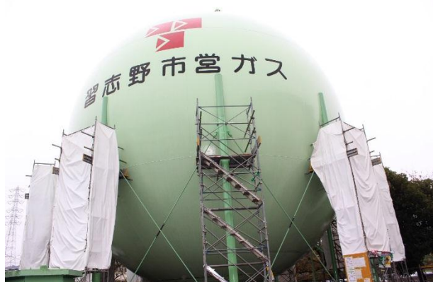
耐震工事の様子
