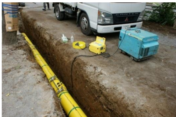
本支管工事の状況（ポリエチレン管へ更新）
