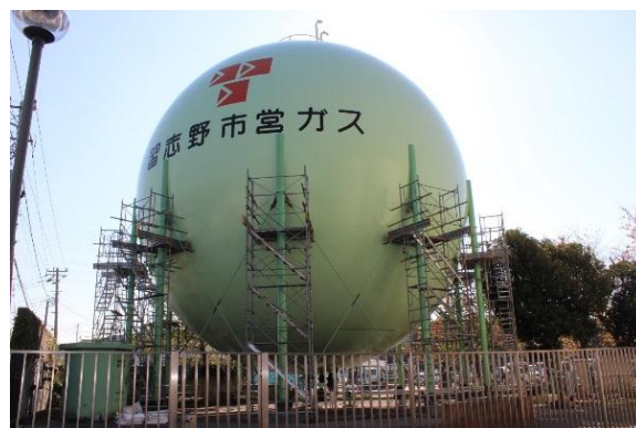
耐震工事の足場の様子
