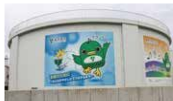
(📷10) 第4給水場の配水池
