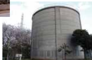
(📷9) 第3給水場の配水池
