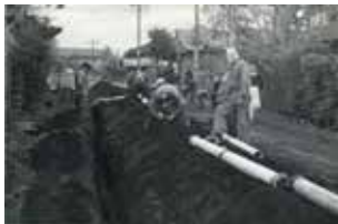
(📷7) 水道管布設作業
