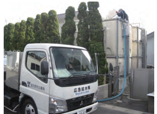
給水車から病院の受水槽へ給水
