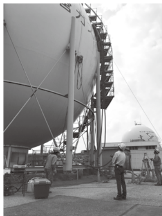
自走ロボットによる外面検査
