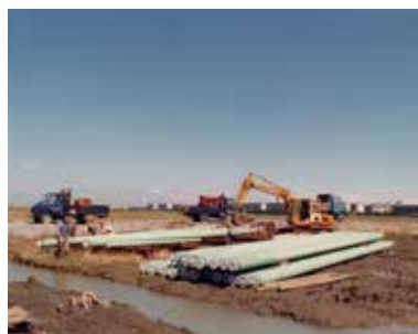
京葉港第2次埋立地の ガス管布設工事
