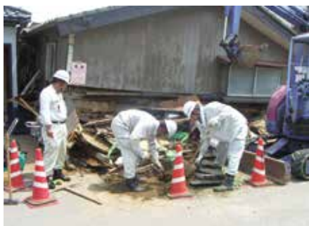
平成19年 新潟県中越沖地震
