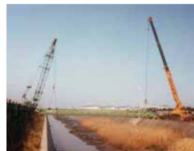
袖ヶ浦6丁目と香澄1丁目 結ぶガス管の架設工事
