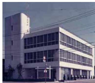
完成した企業局庁舎
