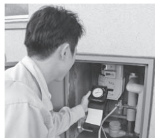
▲ガス漏れ検査の様子
