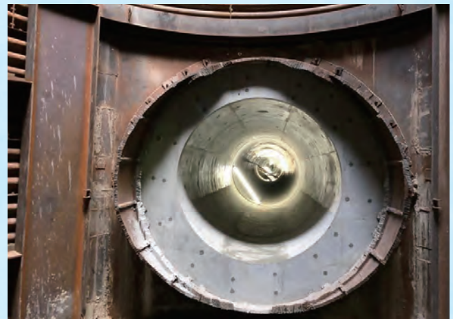
📷2 到達立坑から第2工区を撮影した写真です。型枠をはずし完成した状況です。コンクリートがかなり厚みがあることがわかります。
