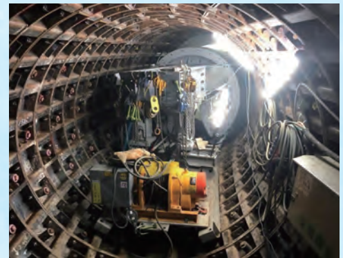
📷1 第2工区坑内上流側からカーブの箇所を撮影した写真です。奥に見えるスチールフォームという型枠を使い、コンクリートを打設していきます。
