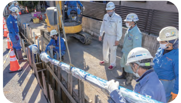
水道管の更新工事の様子
