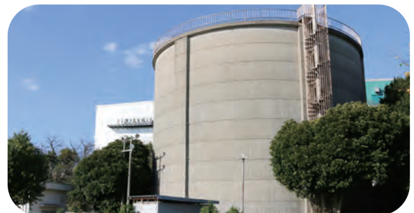
第3給水場の配水池
