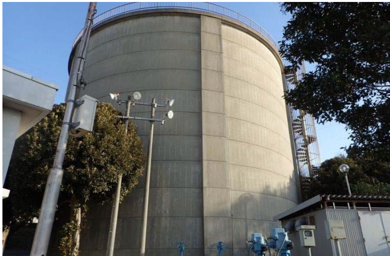
(第3給水場の配水池)
