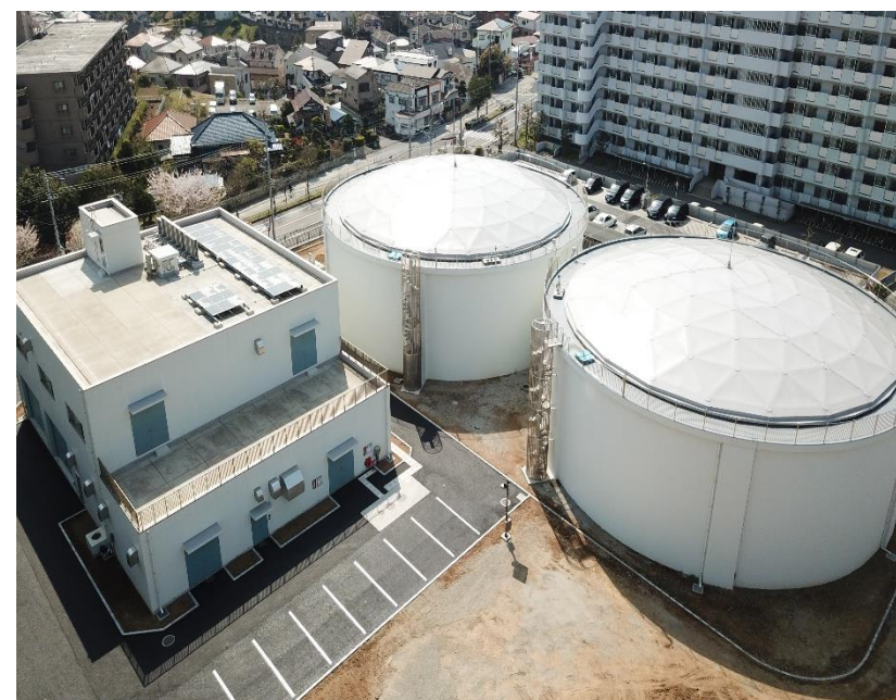
第4給水場の全体写真
