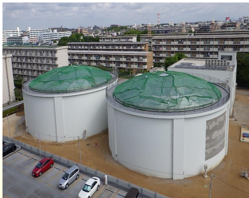
(仮称)第4給水場配水池の様子
