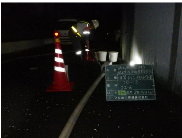
水道管洗浄作業の様子
