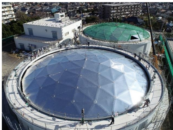
配水池屋根アルミドーム
