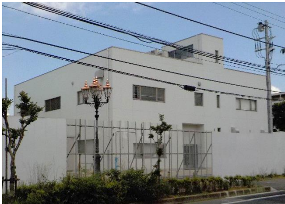
ポンプ電気棟およびガス燈
