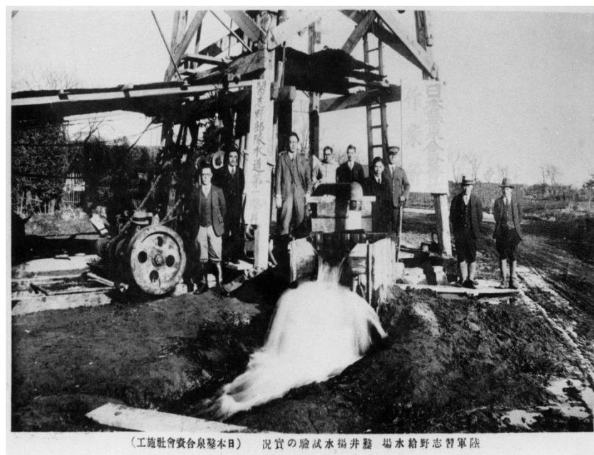
旧陸軍習志野給水場井戸揚水試験
