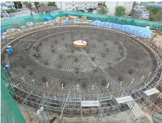
配水池底盤配筋組立
