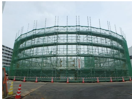
配水池側壁配筋組立
