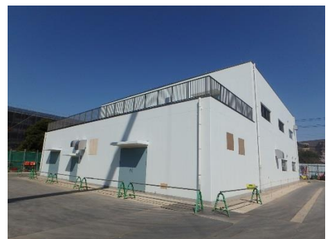
(仮称)第4給水場ポンプ電気棟
