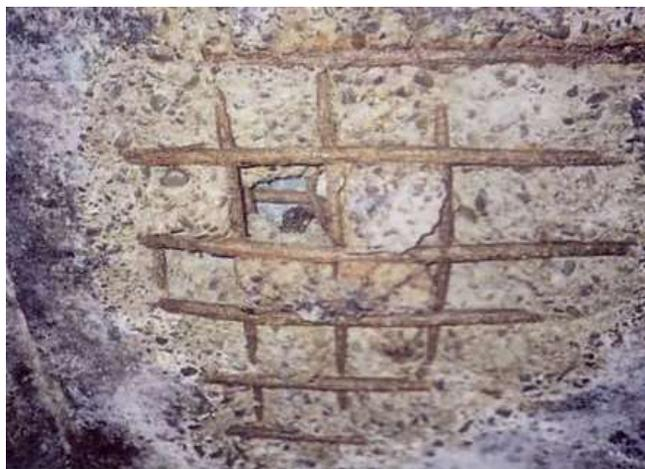
腐食し、鉄筋が露出
