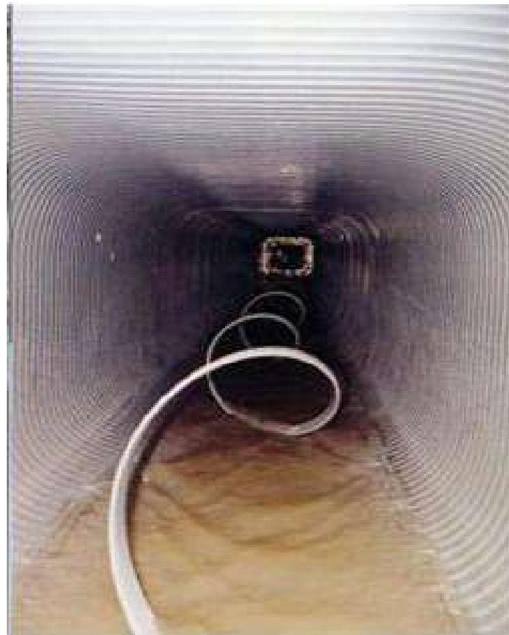
ロボットを用いた劣化下水道管の自動修復技術(更生工法)
