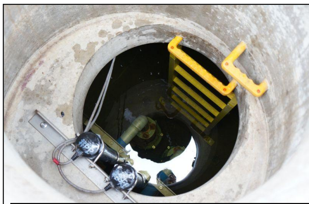
耐震性貯水槽内部
