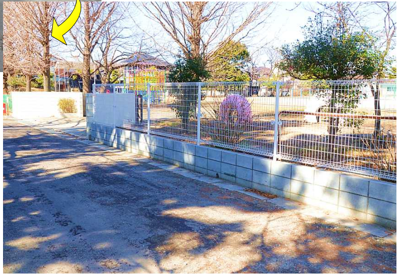
応急復旧作業後
