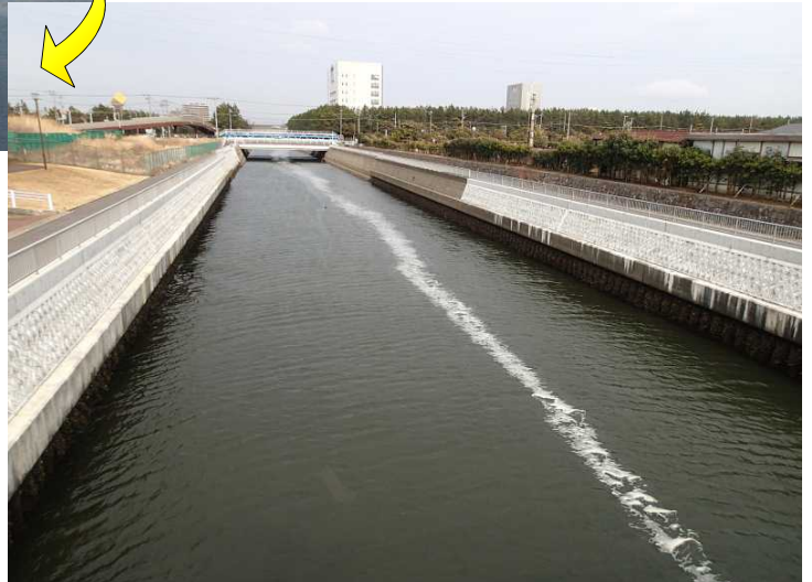
復旧した護岸
