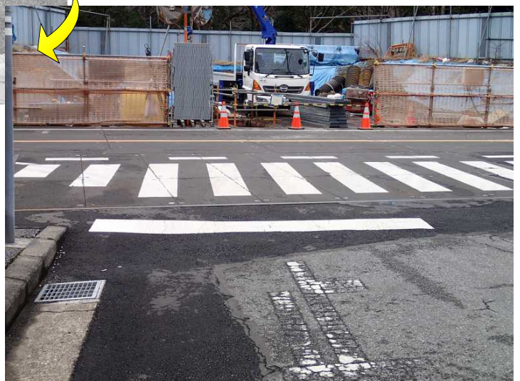
下水復旧工事が継続
