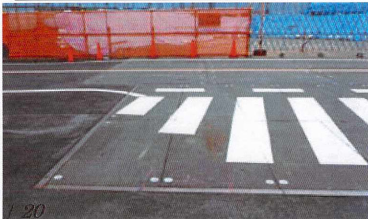
破損した道路等の修復工事
